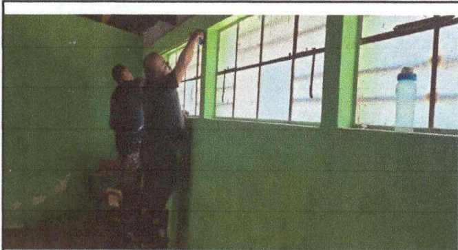
Foto 3: SUSTITUCION DE ESTRUCTURA DE METAL MAS VIDRIOS EN AULAS
