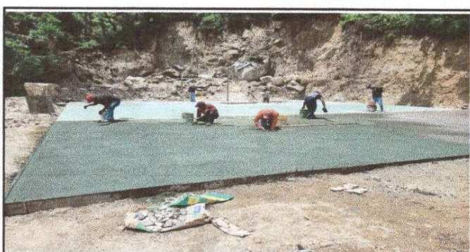
Foto 6: SUSTITUCION DE LOSA DE PATIO
