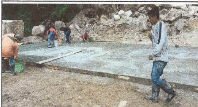
Foto 4: TRABAJOS REALIZADOS PARA SUSTITUCIÓN DE LOSA DE PATIO
