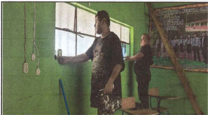
Foto1: SUSTITUCION DE ESTRUCTURA DE METAL MAS VIDRIOS EN DIRECCION
